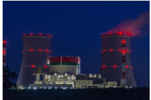
A finales de diciembre comenzó la puesta en marcha física de la 2da unidad de la central nuclear de Bielorrusia. El 27 de diciembre la central anunció la finalización exitosa de la carga de combustible nuclear en el núcleo del reactor, un total de 163 conjuntos de combustible. Por delante están los trabajos de montaje y sellado del reactor con pruebas hidráulicas, la puesta de la planta del reactor a estado caliente y llevándola a un nivel mínimo de potencia controlada.
