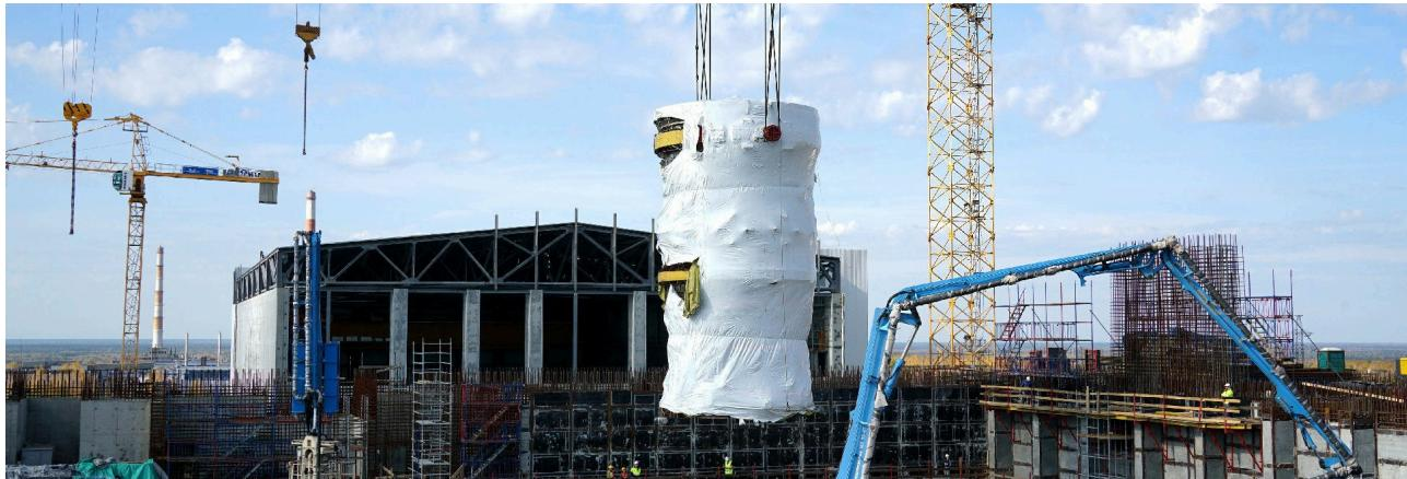
Pada bulan September, ke lokasi pembangunan ODEK di Gabungan Kimia Siberia (Sibkhimkombinat, SHK) telah dikirim komponen-komponen utama untuk pembangunan reaktor cepat eksperimental-demonstratif berpendingin timbal berkapasitas 300 MW – BREST-OD-300. Di antaranya adalah selubung logam rongga pusat instalasi reaktor, selubung dalam untuk keranjang inti reaktor, dan selubung pertama dari empat rongga periferal. Semua peralatan tersebut dibuat di perusahaan-perusahaan divisi rekayasa mesin Rosatom.
